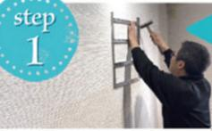
① レール取り付け用ボードアンカー打ち付け
